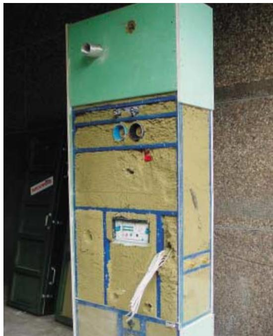
Dieses System löst nicht nur übergreifend die Schnittstellenproblematik der Gewerke Sanitär, Heizung, Lüftung, Elektro und Trockenbau, sondern erfüllt auch hohe brandschutztechnische Anforderungen, z.B I-90, selbst wenn brennbare Komponenten der Baustoffklasse B2 enthalten sind.
