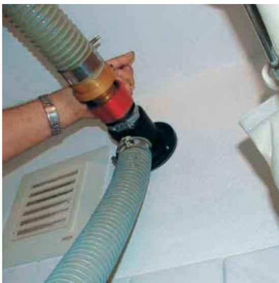
sene und bewährte Lösung für die nachträgliche Dämmung von zweischaligem Mauerwerk, Kirchengewölben, Holzbalkendecken und belüfteten Dächern eingesetzt. Mit einer speziell entwickelten Einblasmachine werden die Steinwolle-Flocken an ihren Bestimmungsort transportiert und zu einer homogenen Schicht für den nachträglichen Wärme-, Schall- und
