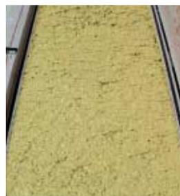
Brandschutz aufgebaut. Hohlräume werden vollständig mit Steinwolle-Flocken ausgeblasen, die sich konturgenau an die Begrenzungsflächen anlegen.
